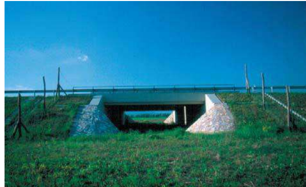
Slika 30 Primjer prolaza ispod nivoa puta u Mađarskoj, namijenjenog isključivo za divljač
