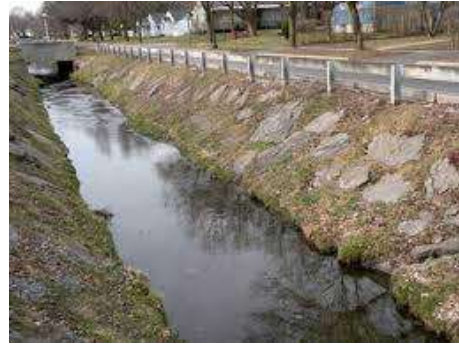
Slika 40 Primjer povoljnije varijante regulacije vodotoka
