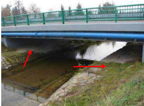
Slika 37 Primjer površine ispod mosta sa suvim prolazom za sisare i druge kopnene životinje
