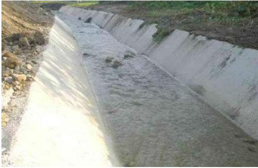
Slika 39 Primjer nepoželjnog rješenja regulacije vodotoka
