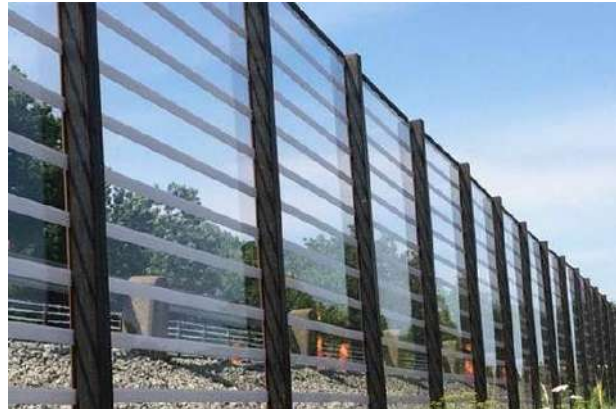
Slika 28 Primjer barijere protiv buke sa trakama koje odbijaju ptice
